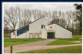
Siège Administratif et Foyer
